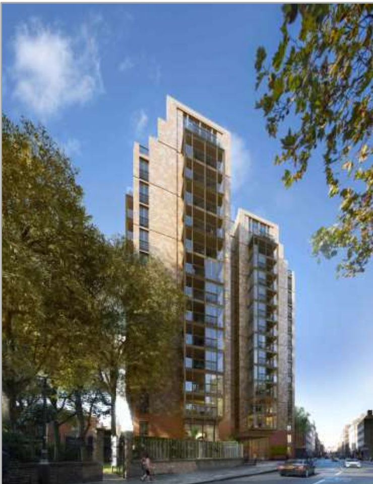
Bauvorhaben: Wohnhochhaus in der Chiltern Street, London
