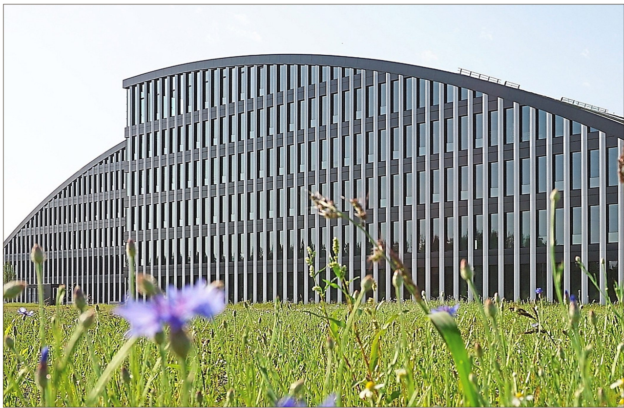
Die Firma Schindler Fenster + Fassaden GmbH hat die Elementfassade geplant, produziert und montiert. Dabei handelt es sich um die weltweit erste 100 Prozent Recycling-Fassade. Foto: Karin Irnstetter
