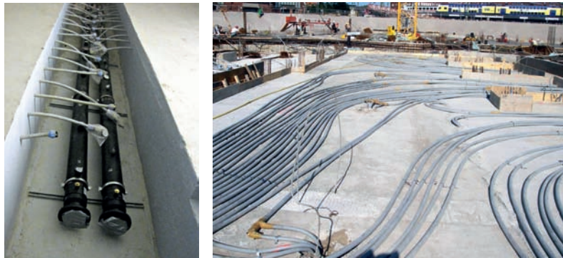
Sonderleitungen in und unterhalb der Bodenplatte
