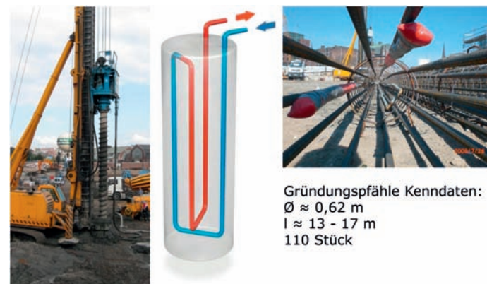
Geothermische Nutzung der Bohrpfähle
