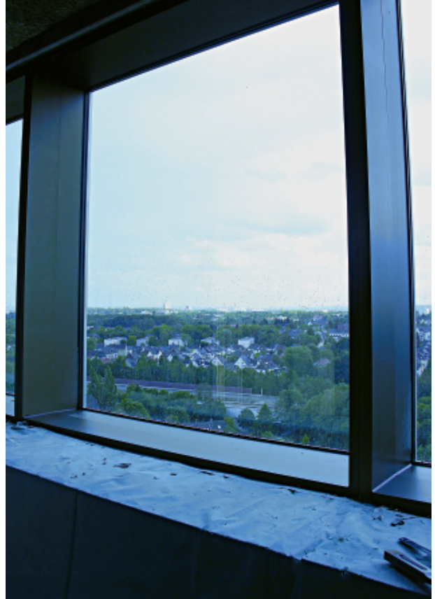
Ausblick aus der neuen Fassade im 12. Stock – hier ist die Laibung verbreitert, die Demontage der alten Elemente nicht mehr erkennbar.
