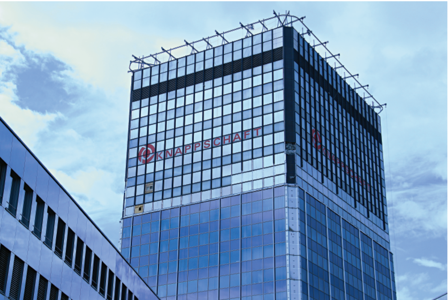
Die Sanierung der geschlossenen Ganzglasfassade des ehemaligen Bominhauses. Ein Projekt, das von allen Beteiligten einen langen Atem erfordert.
