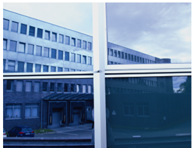
Die Wahl fiel auf das linke Element – bestehend aus der Pilkington Fassadenplatte L200 (u.) und dem Glas Pilkington Suncool™ 50/25 (o.).
