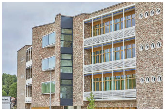
Bild 4. Die Brüstungsbekleidungen bestehen aus freispannenden Aluminium-Lochblechen (Fotos 2–4: © Robert Sprang)
