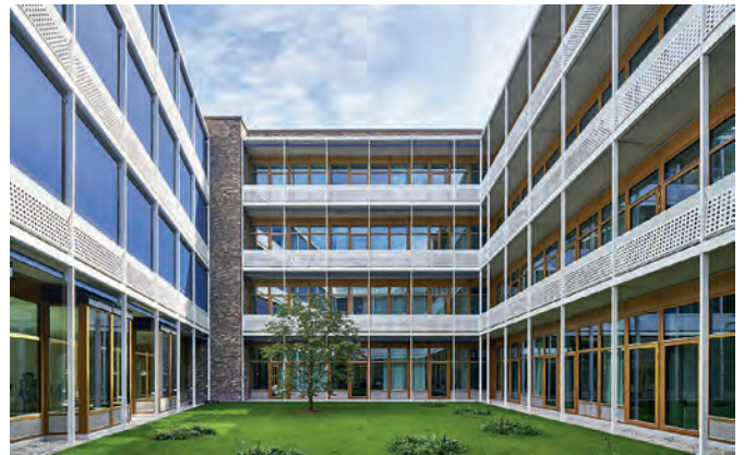
Bild 3. Die Fassade besteht aus über 13.000 m 2 hochwertiger Holz-Elemente
