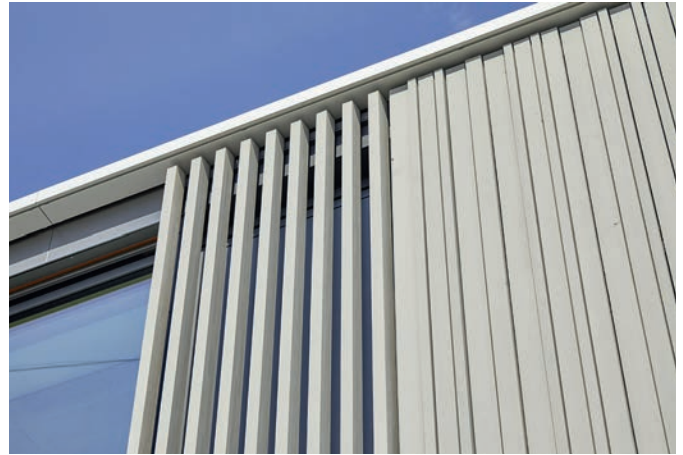
Bild 2. Holzlamellenverkleidung der Grundschule Karlsfeld
