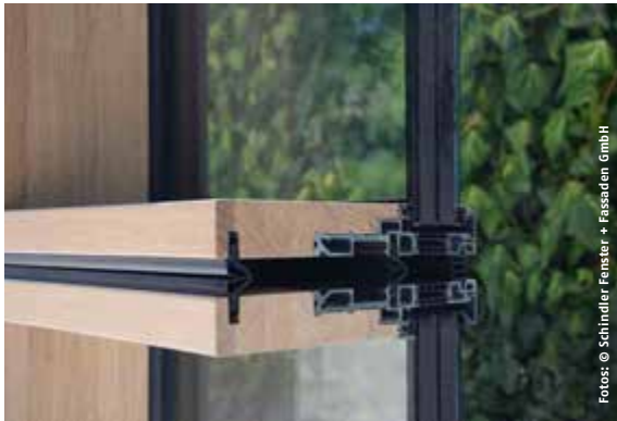
l. Fassadenmuster HMEF 2020, Schnitt / Elementstoß
