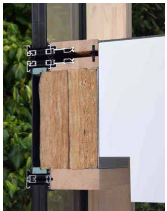
r. Fassadenmuster HMEF 2020, Schnitt / Deckenanschluss
