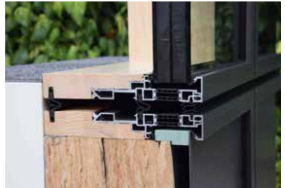
l. Fassadenmuster HMEF 2020, Schnitt / Elementstoß
