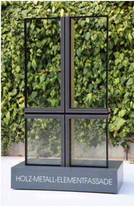
Fassadenmuster der Holz-Metall-Elementfassade HMEF 2020: Ansicht von außen (l.), Ansicht von innen (u.l.) und von außen in der Variante Deckenanschluss (u.r.)
