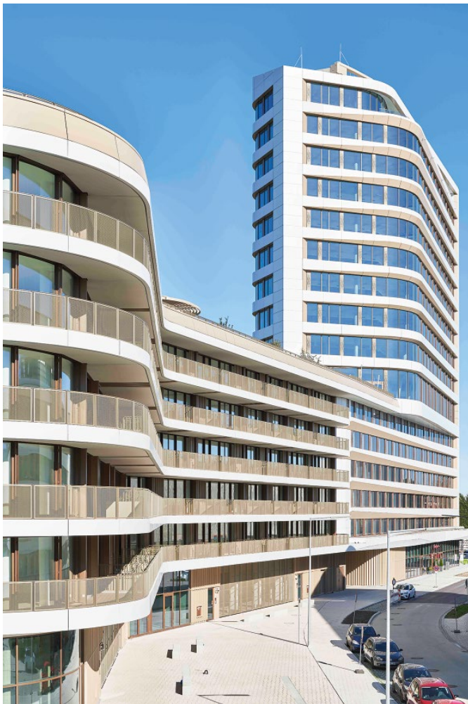
Bild 1. Büro- und Hotelhochhaus NEO, München: Elementfassade mit vorgehängten zweifarbigem Blechkästen
