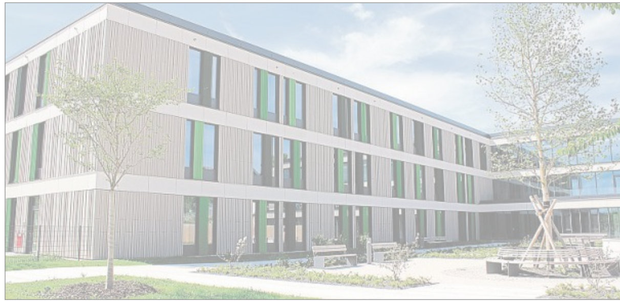
Der Klinikneubau in Wasserburg am Inn.
