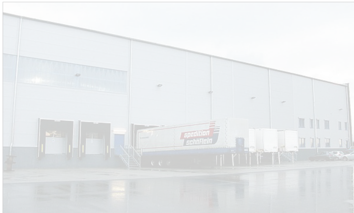
Der Lagerneubau am Standort Rötthlein.
