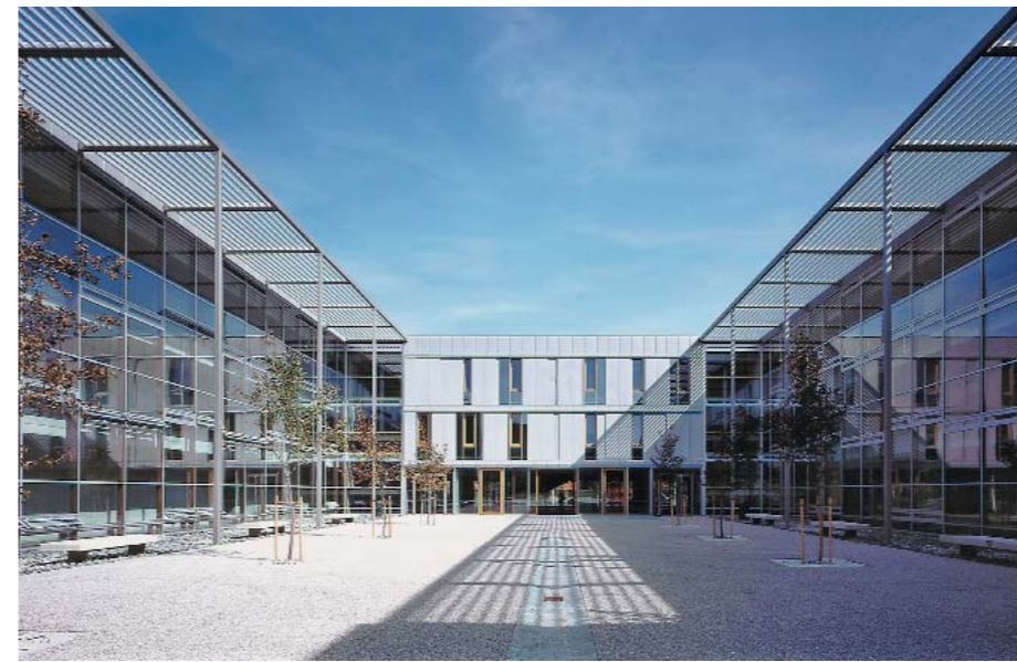
An den Innenhof grenzen die zu den Klassenräumen führenden Flure bzw. Kommunikationszonen an.
