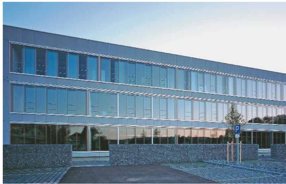
Die Nordfassade, hinter der die Fachklassen angelegt sind, verzichtet auf das verschattende Betonregal.
