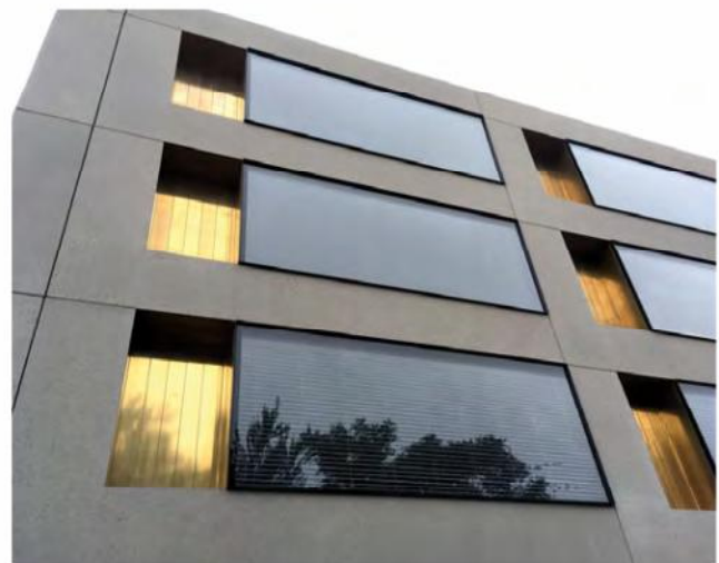
Bild 2 ... durch die Closed Cavity Fassade
