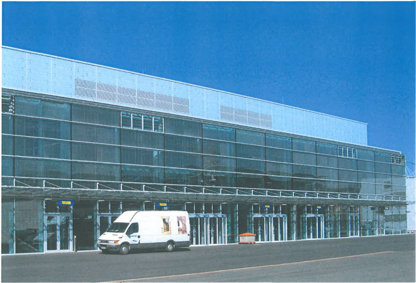
Transparent aber wirkungsvoll vor der Sonne geschützt: Die neue Abfertigungshalle mit ca. 400 m 2 Jalousien-Isolierglas.
